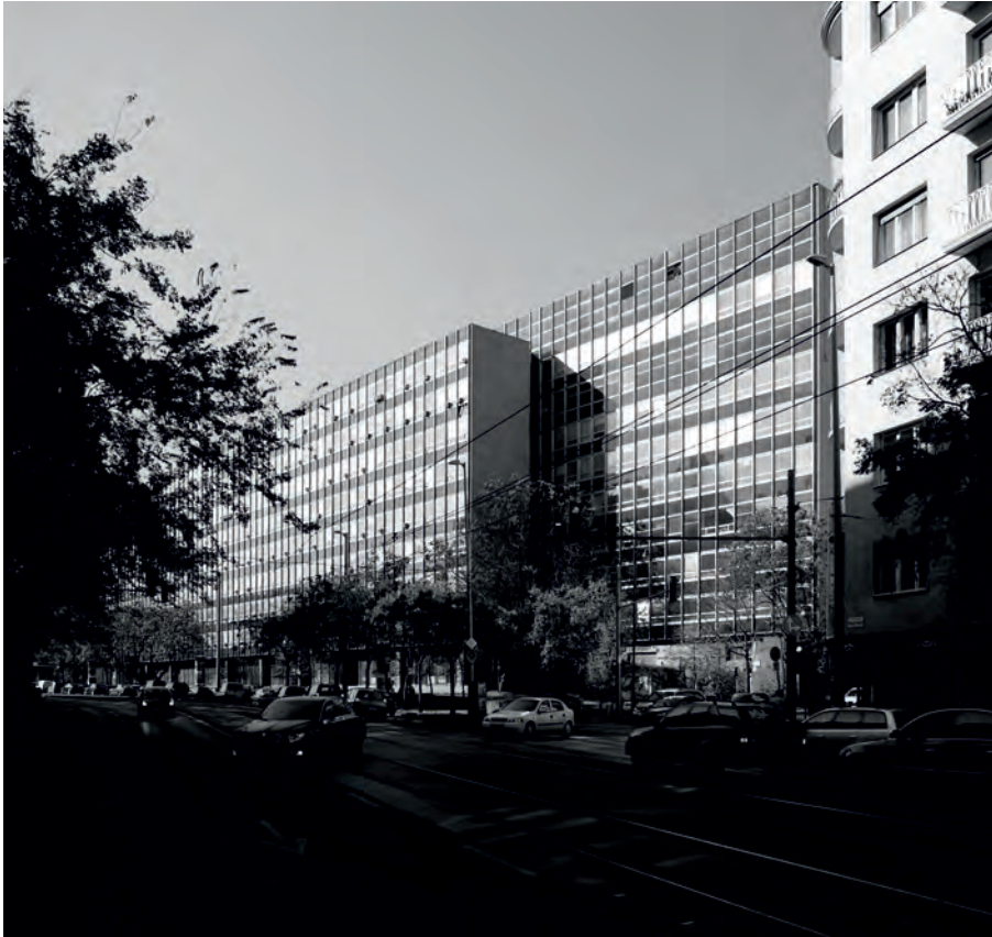
2. ábra. Az egykori Ipari Minisztérium, kiváló épület rossz helyen: felújítás helyett bontás a sorsa
