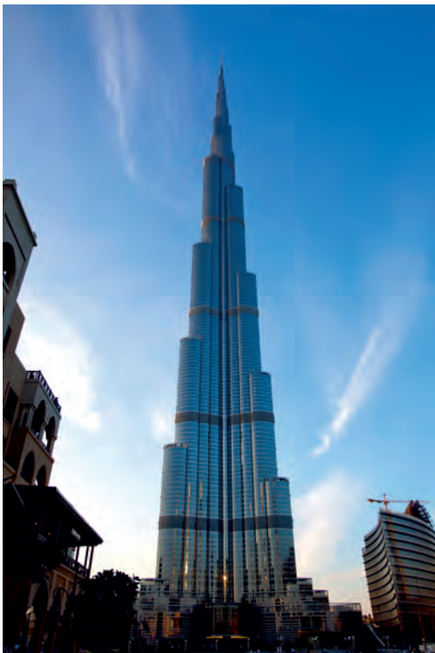
1. ábra. Burj Khalifa, nagy szélterhelés (7,5 kPa) XXL méretű üvegegységekkel, 2009 Dubai
