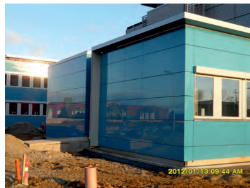
8. ábra. Az Egis BL laborépület Sikasil® SG 500-al ragasztott külső burkolata
