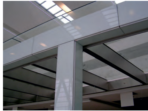
7. ábra. A Liszt Ferenc repülőtér termináljának SikaTack® Panel ragasztóval rögzített belső burkolata
